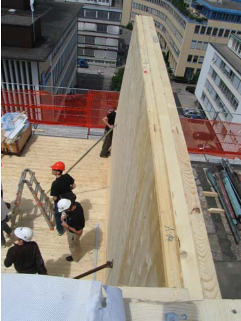
Die Montage der Holzelemente begann von der Mitte des Gebäudes aus (links), setzte sich nachlinks und rechts fort, um so die Genauigkeit über die Länge des Gebäudes (100m ) zu gewährleisten (oben).
