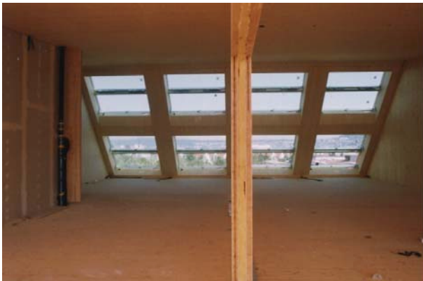
Die in der Schräge (Nordfassade) eingebauten Riesensterne (links) sorgen für eine ausreichende Versorgung der 23 m tiefen Räume mit natürlichem Tageslicht (rechts).
